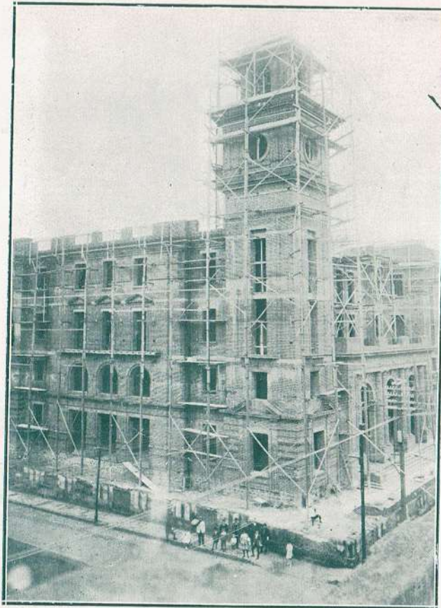
Palacio en construcción, destinado a sede de oficinas públicas.
