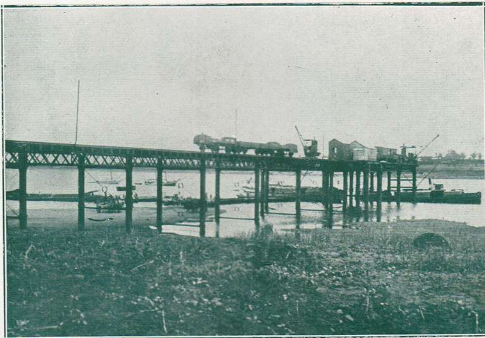
Muelle metálico del Ferro - Carril Noroeste.
