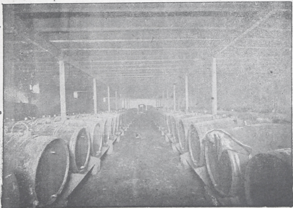
Vista Interior de la bodega HARRIAGUE.
