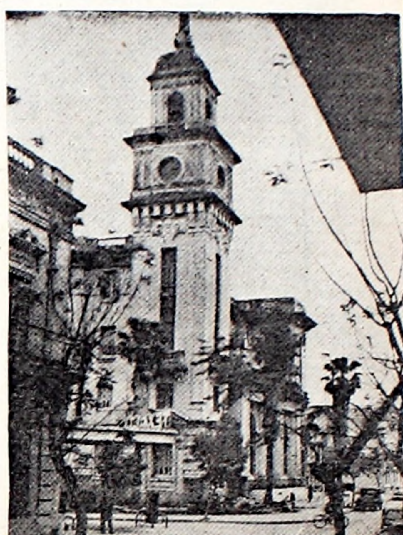
El aire catedralicio de esta hermosa construcción salteña esconde dentro de sus paredes una corriente de actividades cotidianas. Aquí se alberga el Correo. Aquí están también instaladas las Oficinas Recaudadoras del Ministerio de Hacienda y otros organismos estatales.
