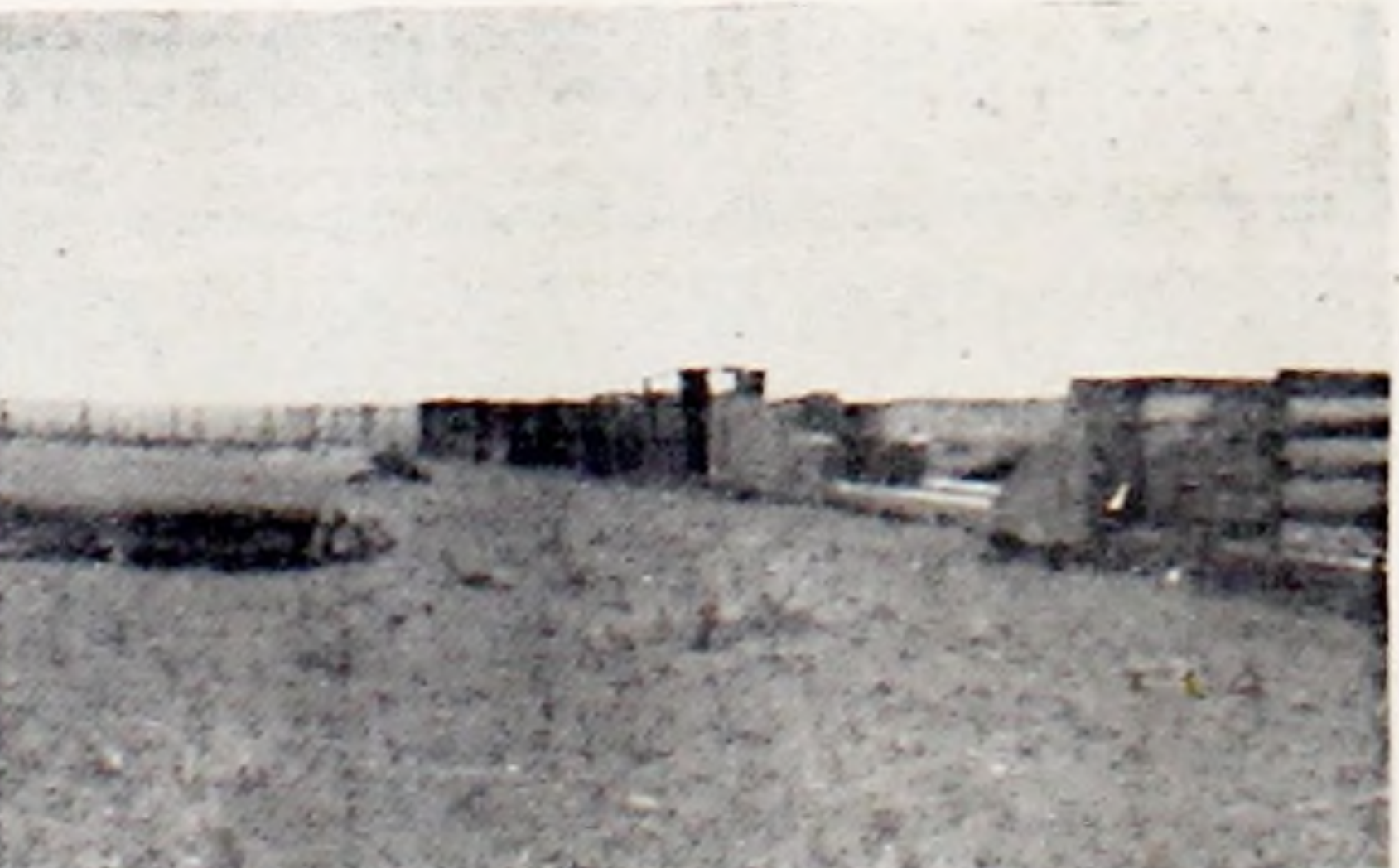
Bañadero con sus modernas instalaciones para bovinos.
