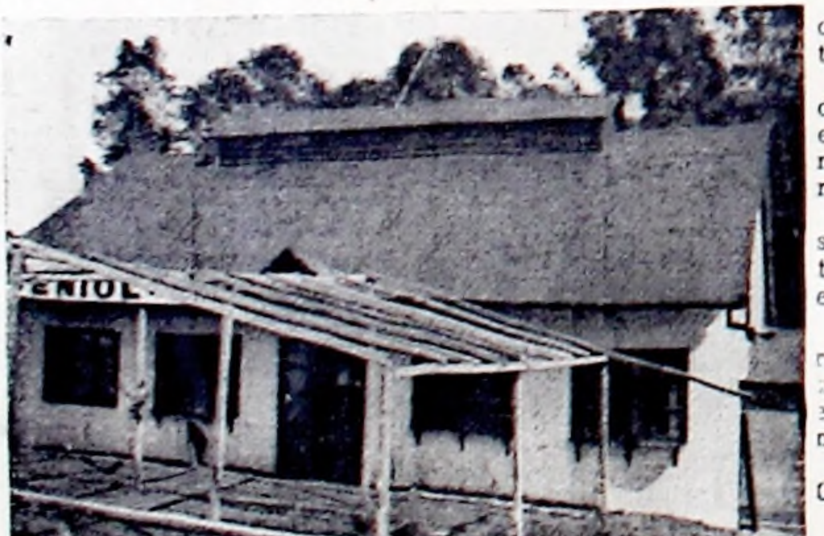
Una vista del exterior de la sección máquinas y parte de la grasería del Saladero Artigas.
