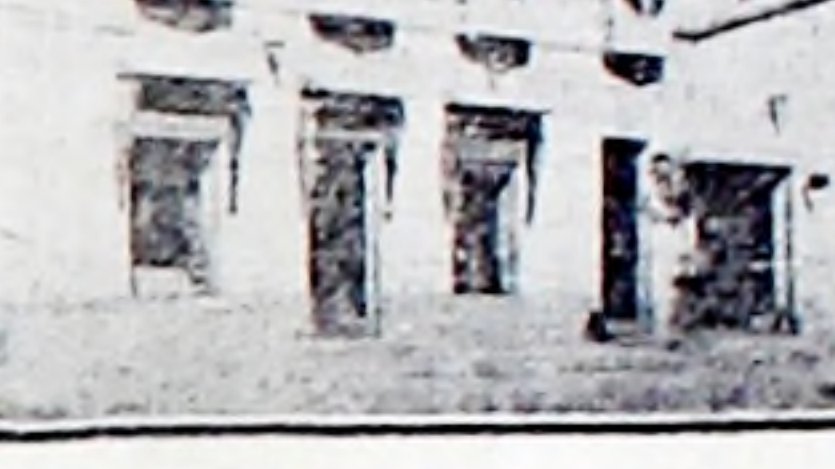
Una vista al frente del edificio propiedad de la firma Zunini Hnos. y Cattaneo, sito en la calle Agraciada, frente a la Plaza de Deportes
