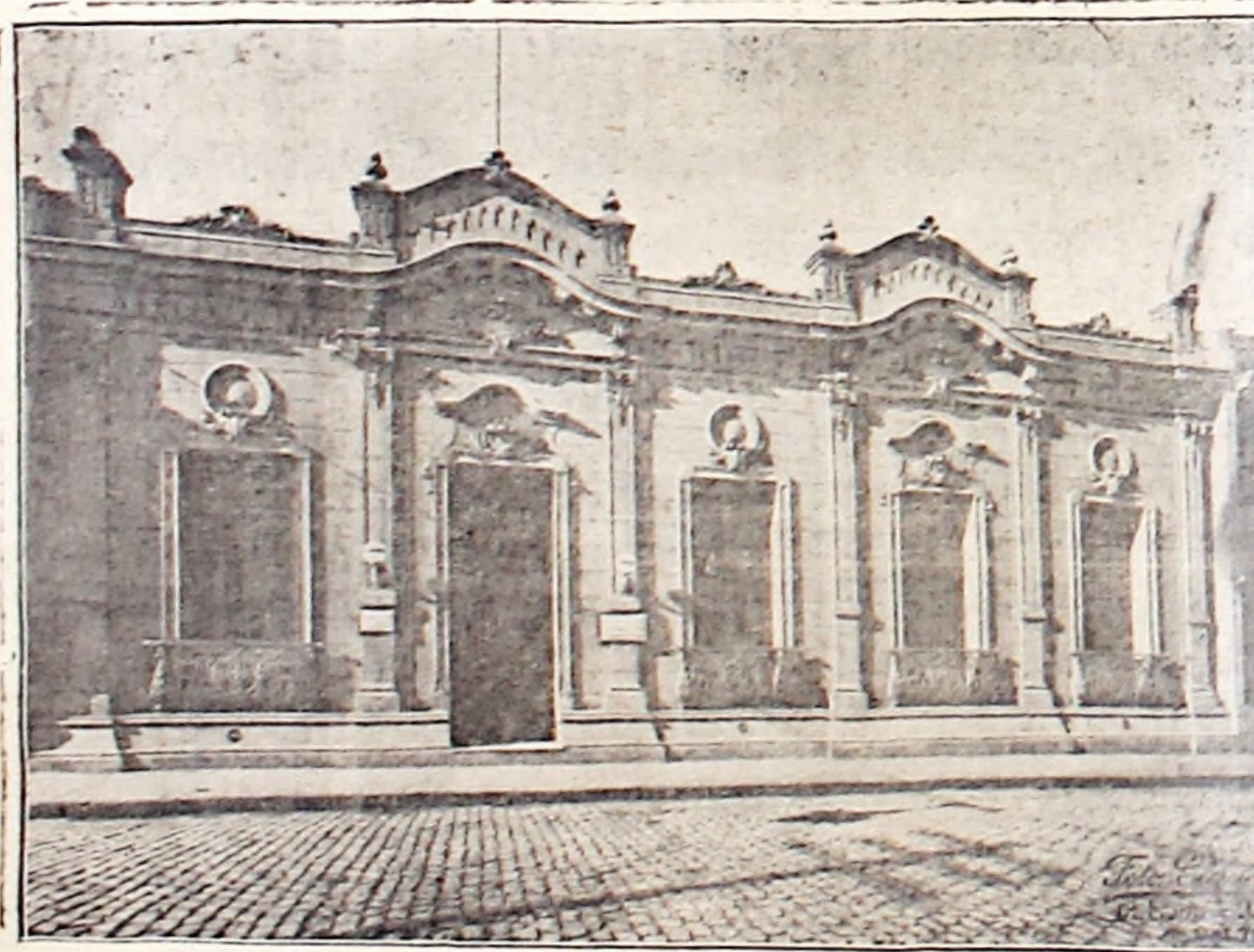
FRENTE DEL EDIFICIO
